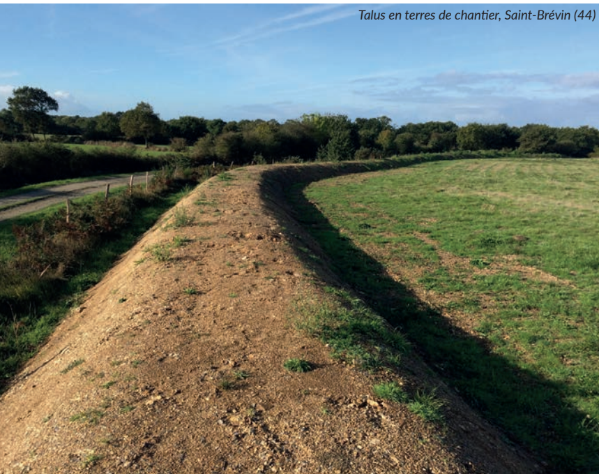
Talus en terres de chantier, Saint-Brévin (44)
